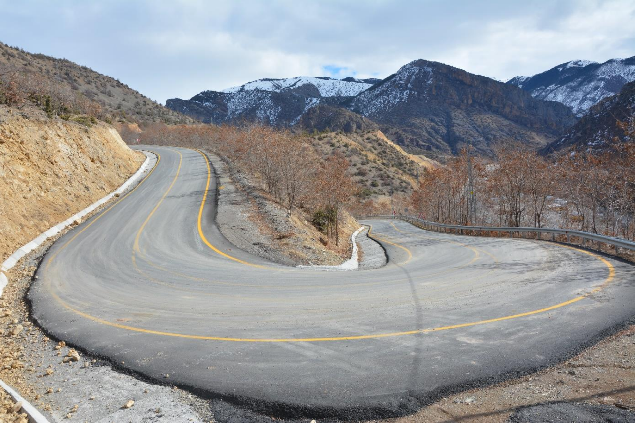
Resim 2: Karaca Mağarası yolu BSK yapım işi
