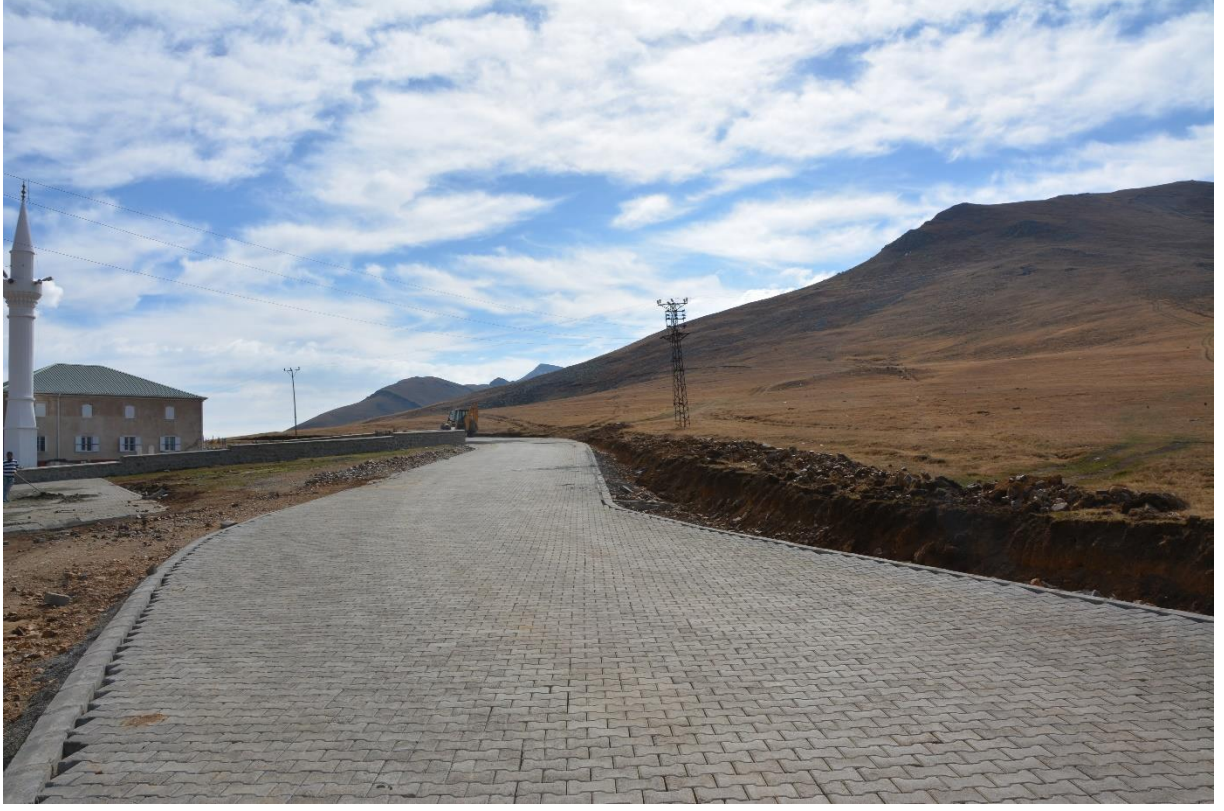
Resim3: Camiiboğazı yaylası parke yapım işi
