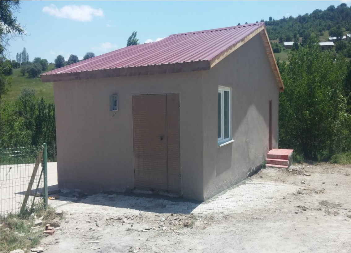
Resim 5: Şiran Babacan Köyü Morg İnşaatı
