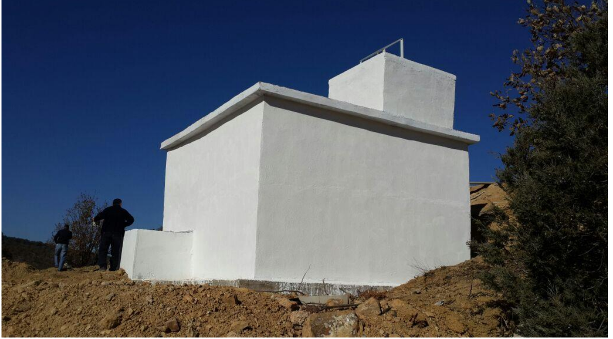
Resim 5: Aş. Duruçay köyü içme suyu deposu
