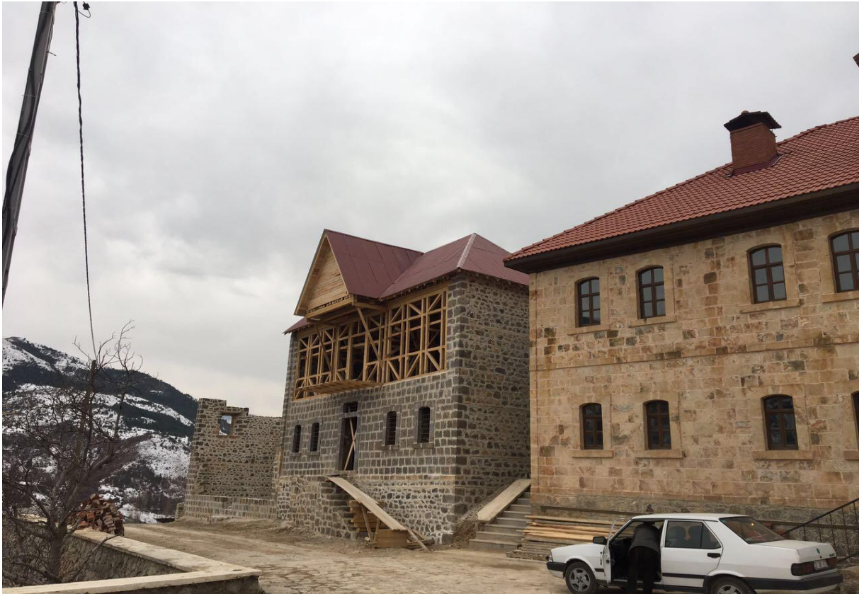
Resim 2: Yeşildere Konağı Ek Binası
